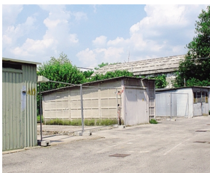
Iniziati i lavori di demolizione dei vecchi garage BARTESAGHI
